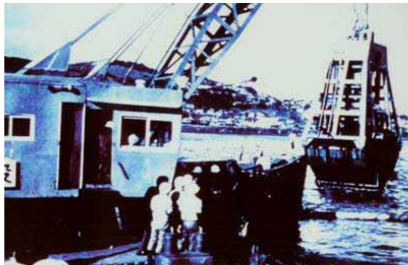
洞海湾の浚渫
