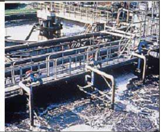
排水処理施設
