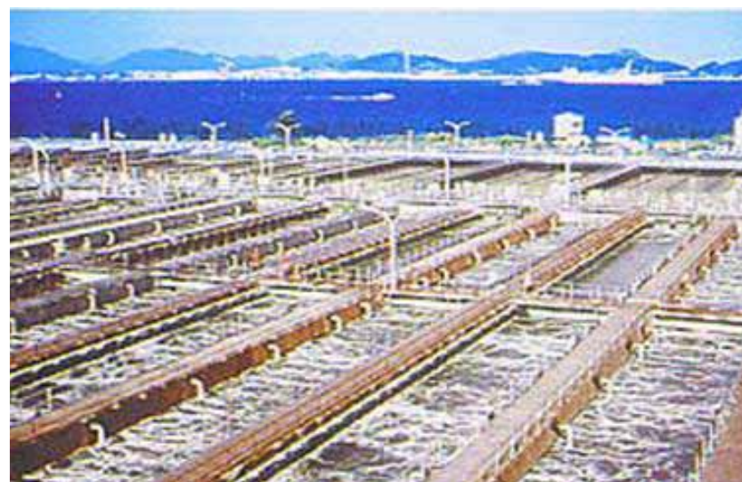
下水処理場の建設
