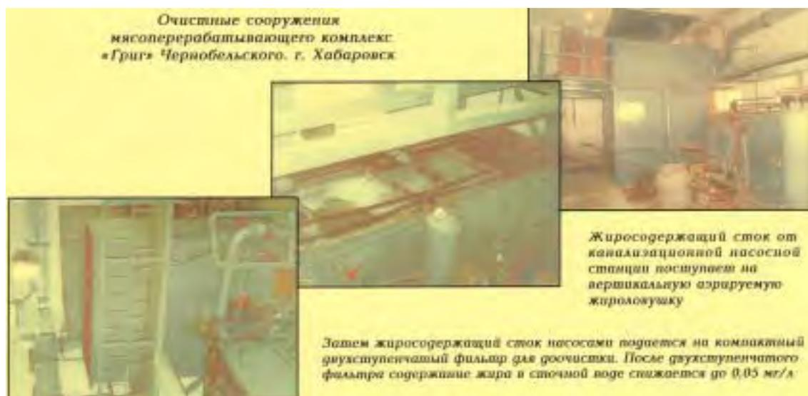
油脂を含んだ排水は排水ポンプ場から垂直エアレーション式グリース阻集器に送られる。次に、油脂を含んだ排水はポンプで小型2段式フィルタに送られ、さらに浄化される。2段式フィルタ通過後の排水中の油脂含有量は0.05mg/lまで低下する。グリース阻集器を通過し部分的に浄化された排水は自重によって水平式浮選装置に流れて行く。ここでは浄化プロセスを強めるために試薬が投入される。
