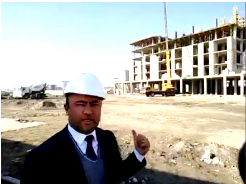
プロジェクト建設現場の様子。奥で建設中の建物は高層マンションで、ブハラ州初の地下駐車場付き物件となるという。
