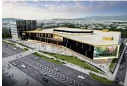
Shymkent Plaza Общая площадь 48 тыс. кв. м. Установлено 48 шт. сенсоров
