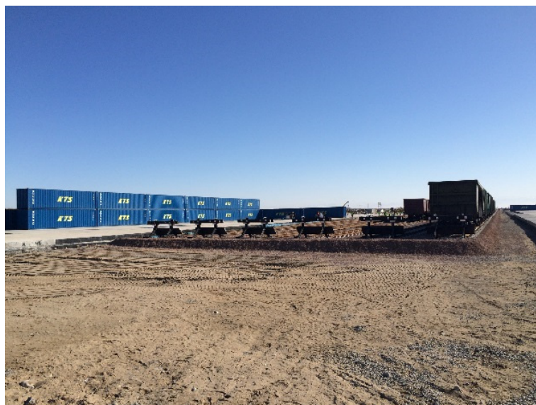
ドライポート完成予定地
