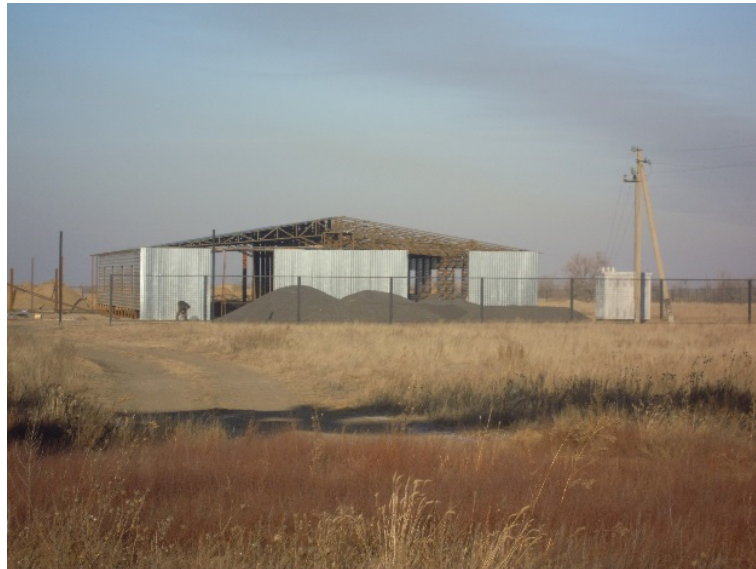
2013年11月訪問時点の「AgroKhim Progress」建屋
