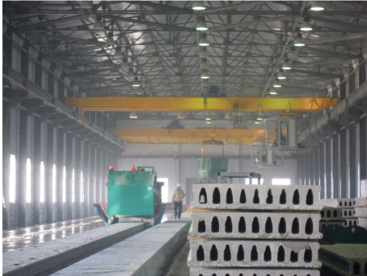
コンクリート製品生産ラインと完成品
