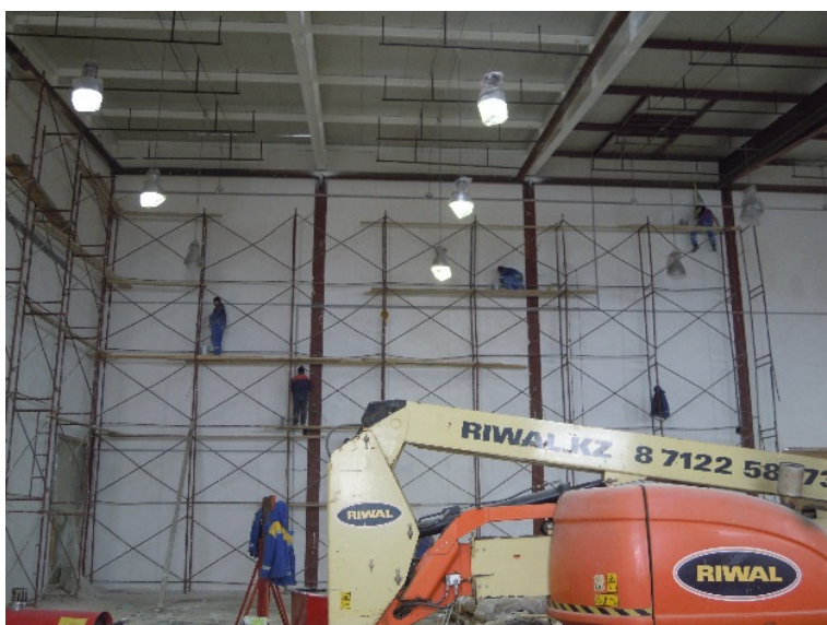
建設工事が進むポリマー製品生産工場内
