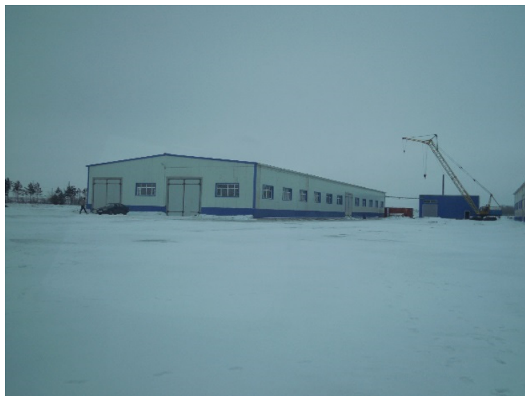
2015年2月訪問時点の「AgroKhim Progress」建屋
